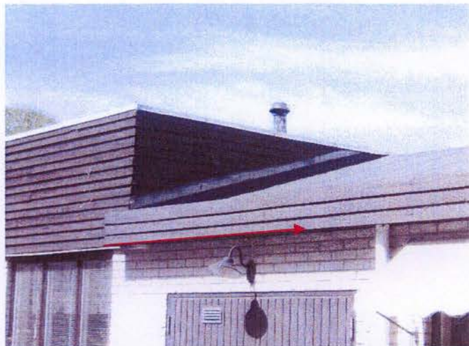
Takfot vid gräns mellan radhusen. Om luftningen i takfoten tätas intill gränsen minskas risken för brandspridning.
